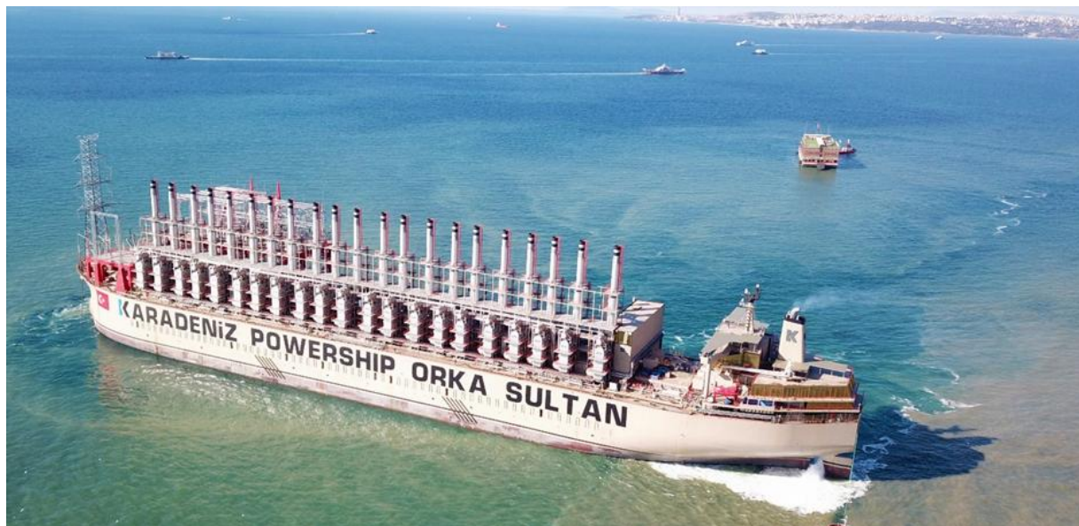
Figura 2: Foto ilustrativa da Central Termoeléctrica Flutuante
